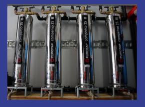
• Das Osmosewasser <  $50\mu$ S/cm wird mittels Ionentauscherharz nachbehandelt bis auf <  $5\mu$ S/cm oder <  $0.2^{\circ}$ fH
