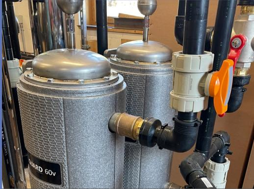
Mehrstufige Vorfiltration für Feststoffe wie Schlamm und Rostwasser, bis hin zu feinsten Verunreinigungen und Schmutzpartikel in der Grösse von 1  $\mu\text{m}$ .
